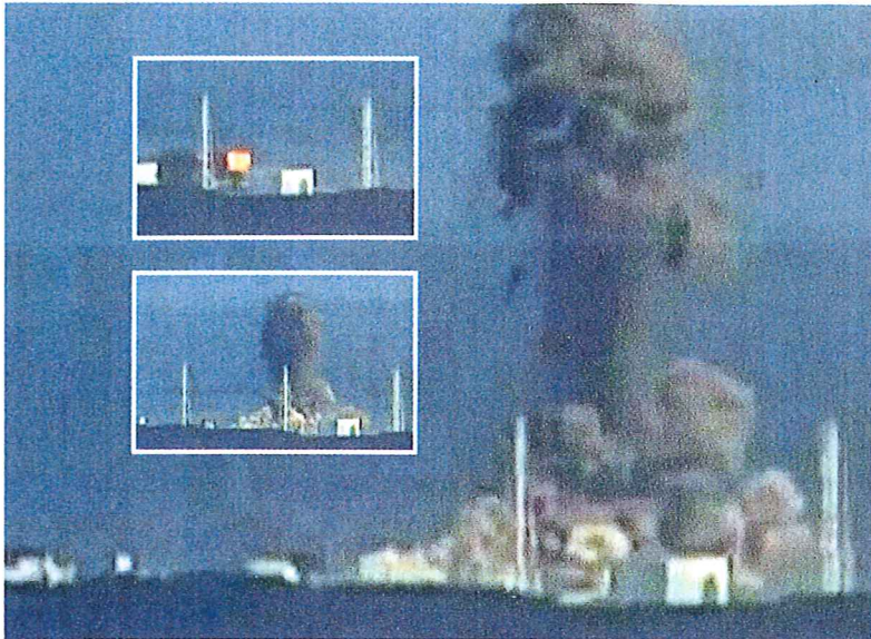
14 MARS : une explosion d'hydrogène se produit dans le réacteur n° 3 de la centrale de Fukushima, soufflant le toit du bâtiment.
