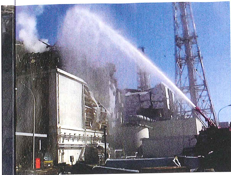
18 MARS : des camions de pompiers munis de canons à eau déversent des tonnes d'eau pour remplir la piscine du réacteur n° 3.
