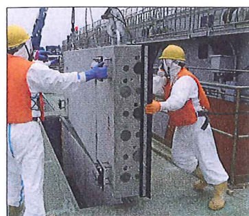
Installation de murs de retenue d'eau contaminée à Fukushima.
